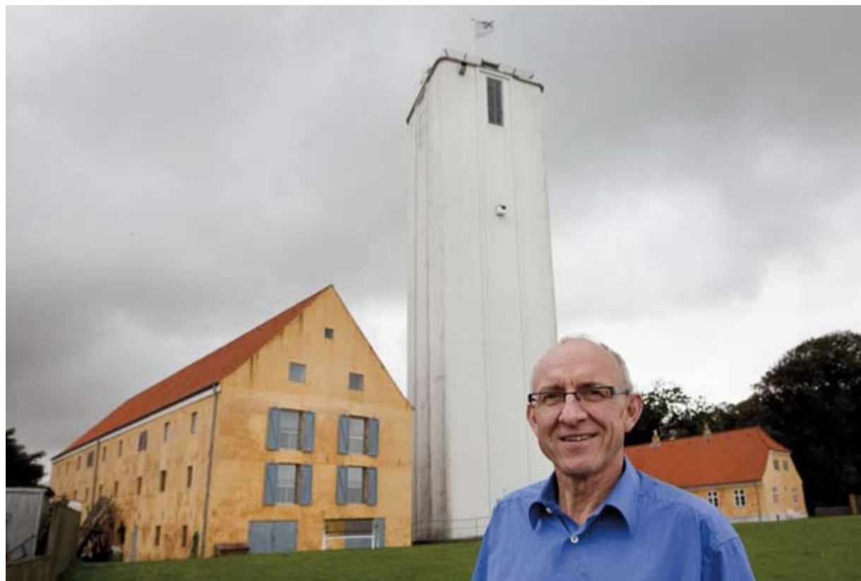
Energimedarbejder Frank Odgaard-Jensen fra Thisted Kommune, foran én af kommunens store og gamle bygninger: Limfjordscenteret Doverodde i Sydthy. Energimærket, der ligger klar til "Energiske September", vil formentlig vise, at her kan spares en hel del energi.
